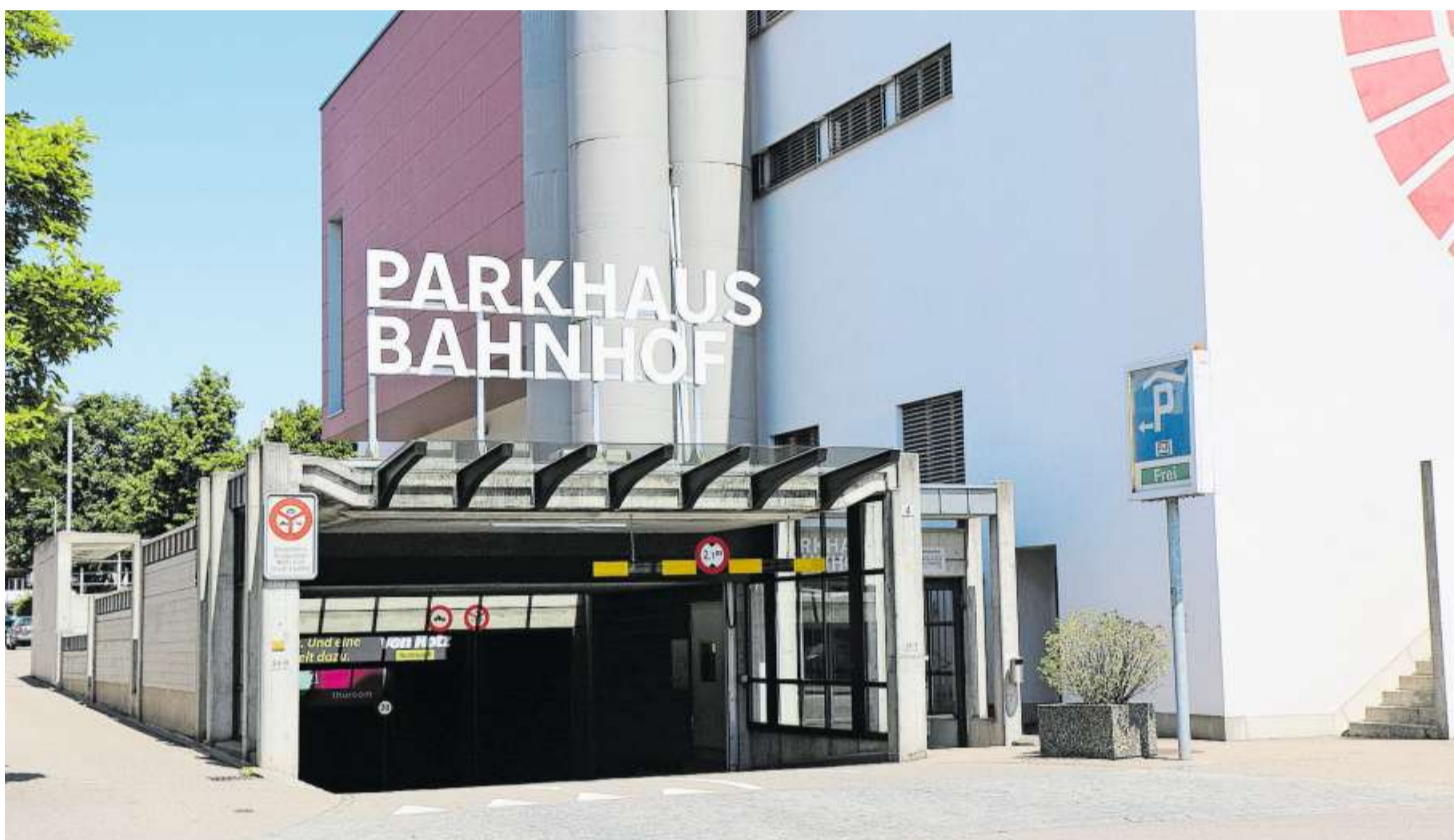
Das Parkhaus am Wiler Bahnhof soll mit zwei neuen Untergeschossen erweitert werden.
